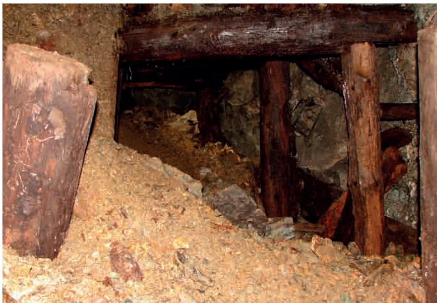
Ryc. 80. Częściowo zasypany chodnik w dawnej kopalni Wolność w Kowarach
