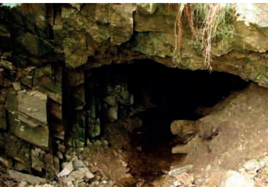
Ryc. 20. Wejście do sztolni pouranowej w Budnikach
