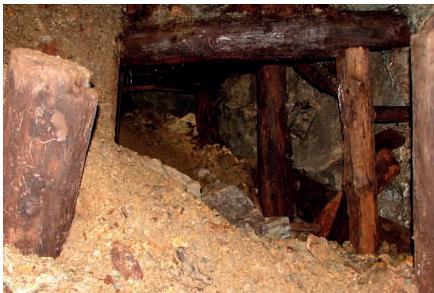
Obr. 80 Částečně zasypaný průchod v bývalém dole Wolność (Kowary)
