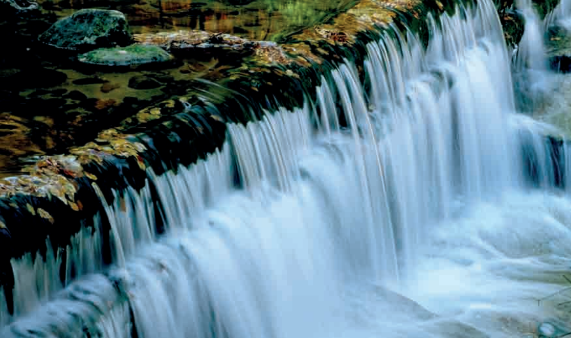
Fot. 39. Przegradzanie w poprzek koryta potoku sztucznymi progami i zabudową przeciwrumoszową, stanowi przeszkodę uniemożliwiającą migrację ryb. Powstanie takiej konstrukcji jest niemal jednoznaczne z ustąpieniem ryb z odcinka cieku wodnego położonego powyżej zabudowy
