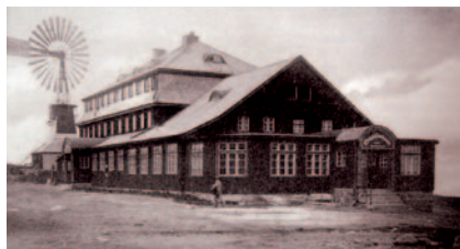
Fot. 44. Koło napędzane wiatrem o średnicy 15 metrów zostało zawieszone na maszcie o wysokości 22 metrów. Urządzenie napędzało generator, który ładował akumulatory dostarczające schronisku prąd. Po kilku miesiącach koło zerwała wichura a napęd wiatrem zastąpiono motorem Diesla (1924 r.)
